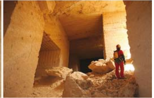
Fig. 6 - Esempi di dissesti osservati nella cava sotterranea, con presenza di fratture in volta e sui pilastri, distacchi circolari in volta, e crollo totale del tetto della cava. Fig. 6 - Examples of failures observed in the underground quarry, including fractures on the vault and the pillars, circular detachment from the vault, and massive breakdown of the quarry vault.
