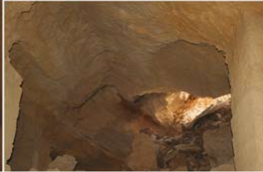
Fig. 6 - Esempi di dissesti osservati nella cava sotterranea, con presenza di fratture in volta e sui pilastri, distacchi circolari in volta, e crollo totale del tetto della cava. Fig. 6 - Examples of failures observed in the underground quarry, including fractures on the vault and the pillars, circular detachment from the vault, and massive breakdown of the quarry vault.
